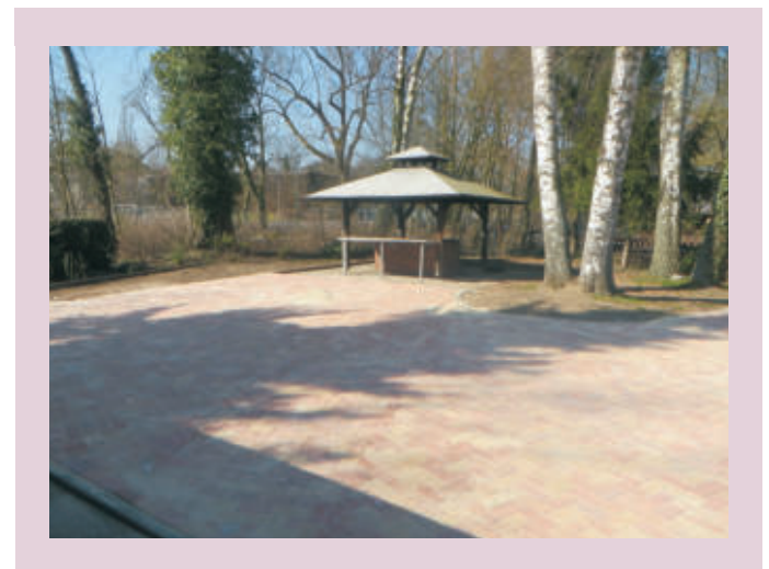
Außenanlage der Grillhütte nach der Sanierung 2015
